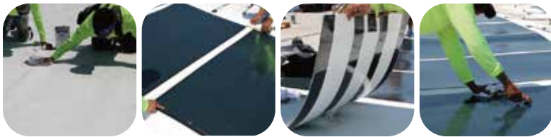
①屋根の清掃 ②パネルを調整 ③剥離膜を剥がす ④しっかり貼付け
